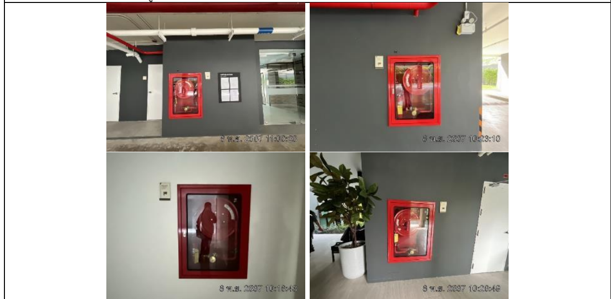
รูปที่ ผ7.50 ตู้เก็บสายฉีดน้ำดับเพลิงพร้อมอุปกรณ์ (Fire Hose cabinet : FHC)
