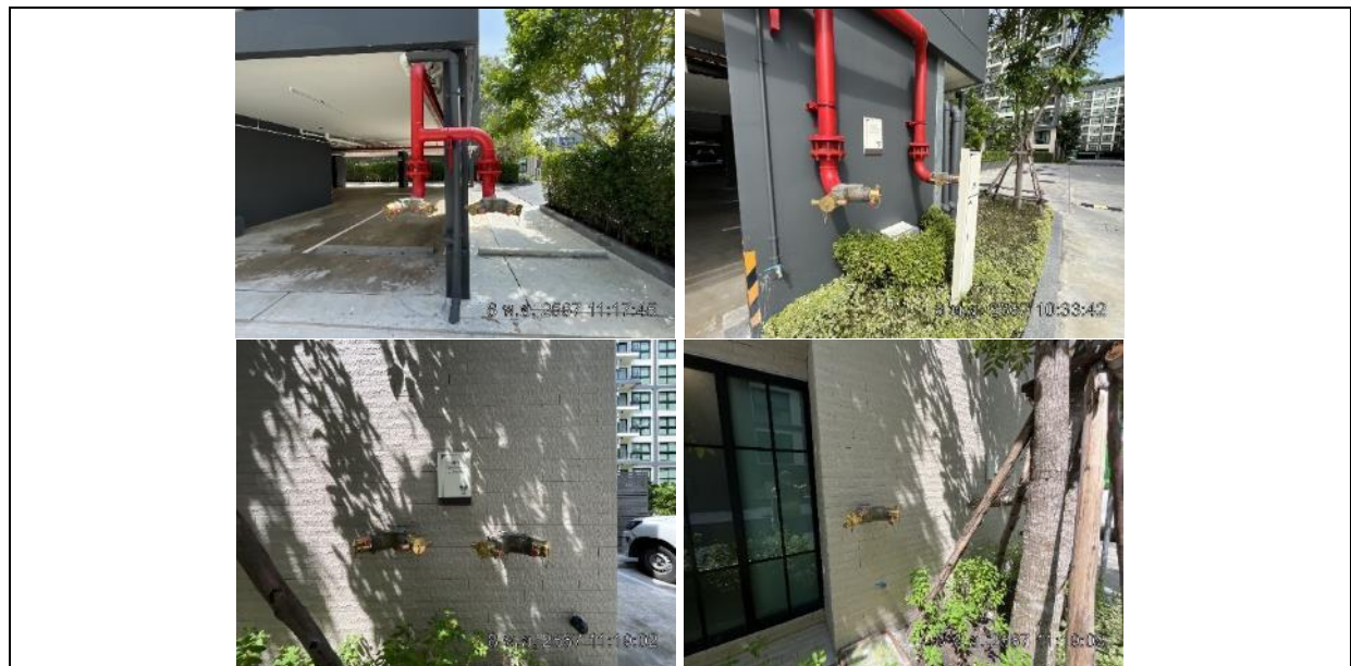
รูปที่ ผ7.49 หัวรับน้ำดับเพลิงภายนอกอาคาร อาคาร A B C และ D
