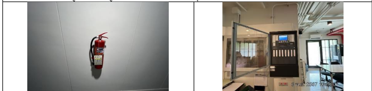
รูปที่ ผ7.51 ถังดับเพลิงมือถือ (Dry Chemical) ขนาด 10 ปอนด์
