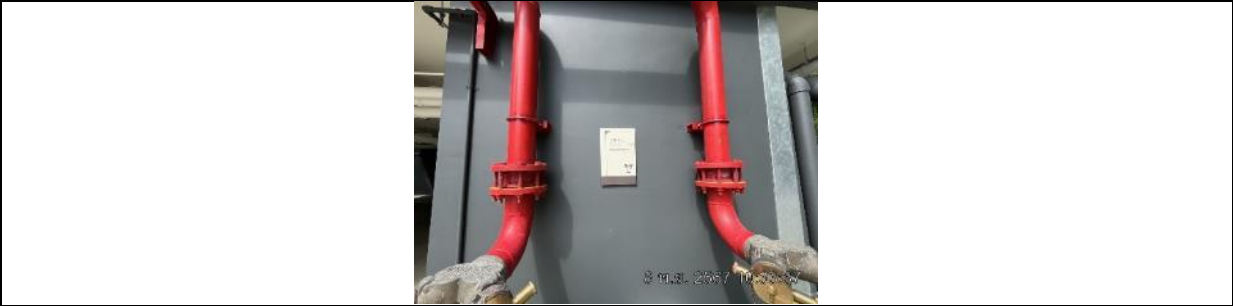
รูปที่ ผ7.48 ระบบท่อยืน (Stand Pipe) รับน้ำดับเพลิงจากหัวรับน้ำดับเพลิงภายนอกอาคาร
